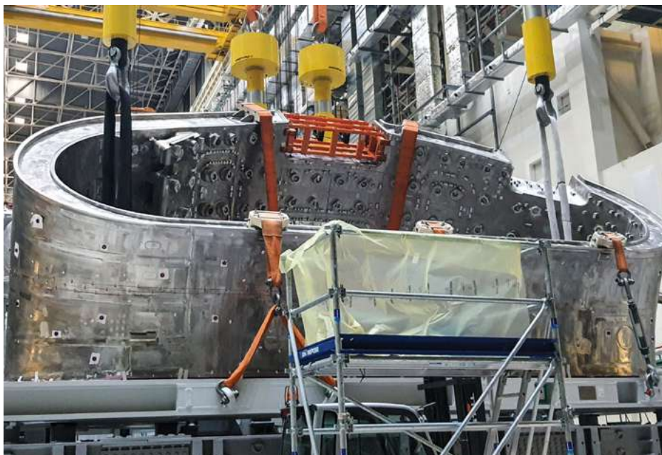
1. attēls. ITER kodoltermiskā reaktora būvlaukums Kadarašā: tokamaka būvbedre ar uzstādītu centrālo solenoīdu un vairākiem plazmas kameras sektoriem (pa labi); viens no deviņiem vakuumkameras sektoriem īsi pirms ievietošanas būvbedrē (pa kreisi)
