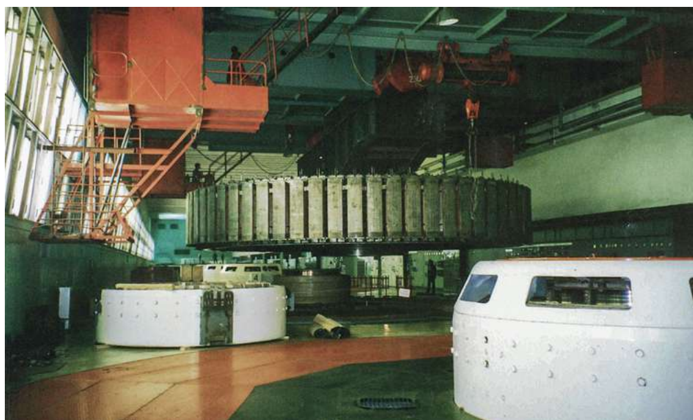
Hidroagregāta Nr. 10 ģenerators rotora pārvietošana Pļaviņu HES rekonstrukcijas ietvaros. 1996. gads
