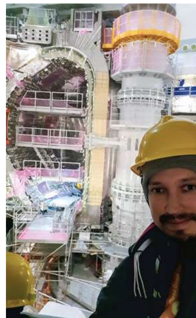
1. attēls. ITER kodoltermiskā reaktora būvlaukums Kadarašā: tokamaka būvbedre ar uzstādītu centrālo solenoīdu un vairākiem plazmas kameras sektoriem (pa labi); viens no deviņiem vakuumkameras sektoriem īsi pirms ievietošanas būvbedrē (pa kreisi)
