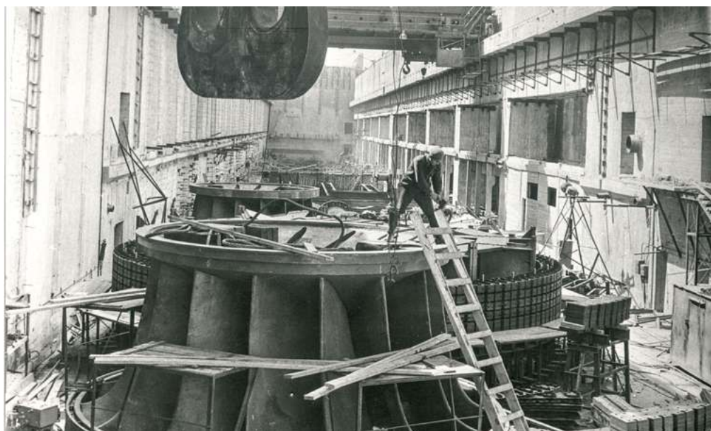
Pļaviņu HES turbīnas darba rata montāža. 1965. gada 11. jūnijs
